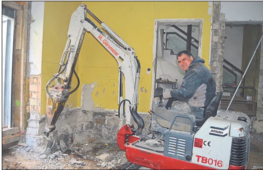
Paul Masuch von der Firma Dahlkötter sorgt zurzeit dafür, dass der alte Boden aus dem Historischen Rathaus verschwindet. Um das Gebäude barrierefrei zu gestalten, wird die untere Etage an das Niveau der Straße angepasst – und der alte Boden muss weichen. Fotos: Gruhn
