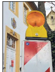
Achtung, Baustelle: Das Historische Rathaus ist zurzeit für Publikumsverkehr geschlossen.
