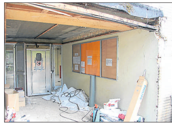
Der alte Eingang der Halle ist jetzt eine Baustelle. Im August 2014 soll die Sanierung abgeschlossen sein.
