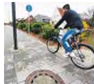
Engstelle: Auf der Nordseite der Gütersloher Straße stehen mehrere Laternen mitten auf dem Geh- und Radweg.
