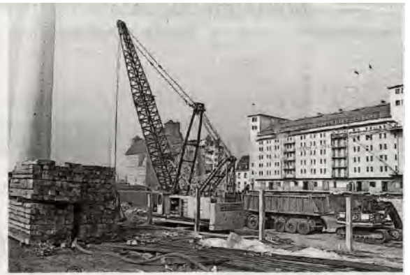
Ein Jahr später: Neben dem neuen Rheinturm wird jetzt schon das Baumaterial gestapelt. Foto: Eva Tüsselmann
