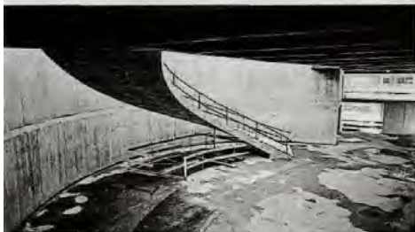
Die Bürgerhalle mit der noch sehr rohen Treppe, die zum Plenarsaal führt. Foto: Achim Schüler
