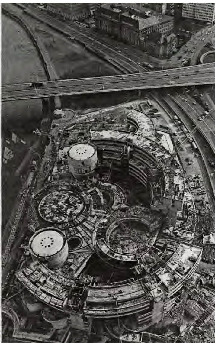
Die Struktur des Gebäudes ist im März 1984 schon gut zu erkennen.
