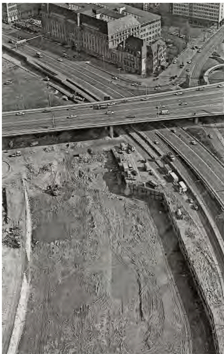
Das aufgefüllte Hafenbecken wird zum Baufeld (März 1982).
