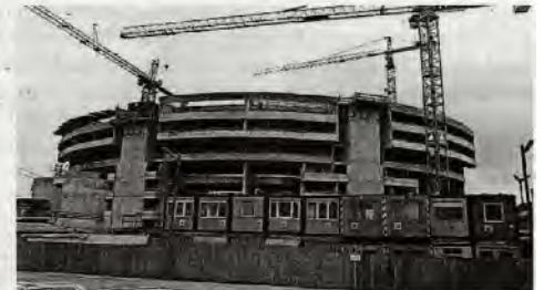
So weit war der Bau im März 1984 fortgeschritten. Bis zur ersten Sitzung dauerte es noch drei Jahre. Foto: Eva Bruckhaus
