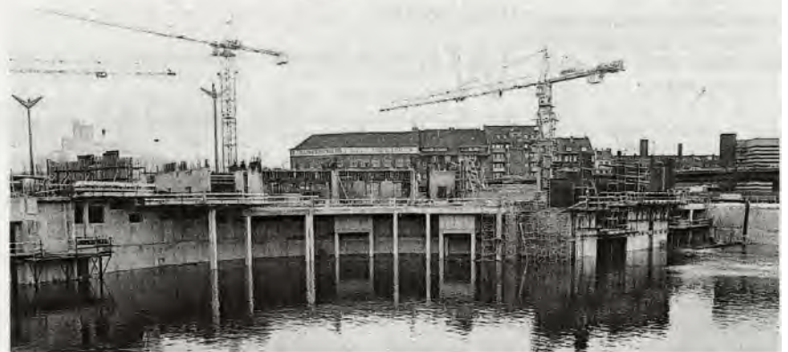
Wasser spielte auch nach dem Baubeginn immer wieder eine Rolle. Hier: die geflutete Baustelle in einem frühen Stadium (Februar 1982). Foto: Eva Bruckhaus
